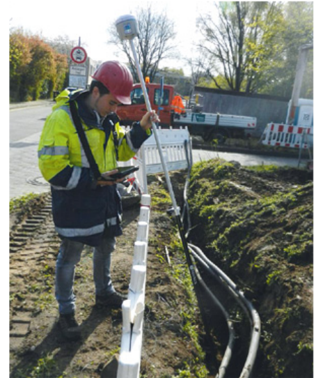
Anwendungsbeispiel Grabenvermessung: Der STONEX S10 kann schräg vom Rand an den Messpunkt geführt werden. Die Software berechnet dies automatisch mit. Bild: stonex
